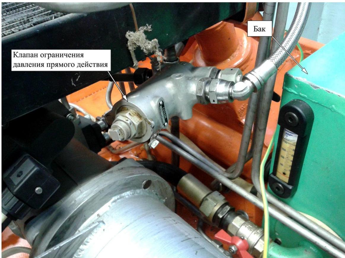
Рис. 8. Внешний вид клапана ограничения давления прямого действия
